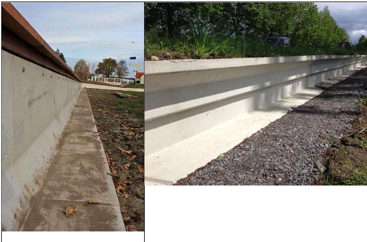
Figuur bijlage 1: Twee voorbeelden van geschikte betonnen schermen. Beide hebben aan de bovenzijde een overstekende rand om te voorkomen dat dieren over de rand kunnen klimmen en aan de voet een horizontale rand om de groei van vegetatie te voorkomen en onderhoud te vereenvoudigen (Foto 's: Richard Struijk (links, Veenhuizen) en Maibach GmbH (rechts)).
